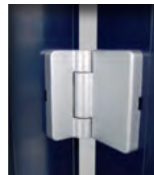
Drehband des Faltflügels
